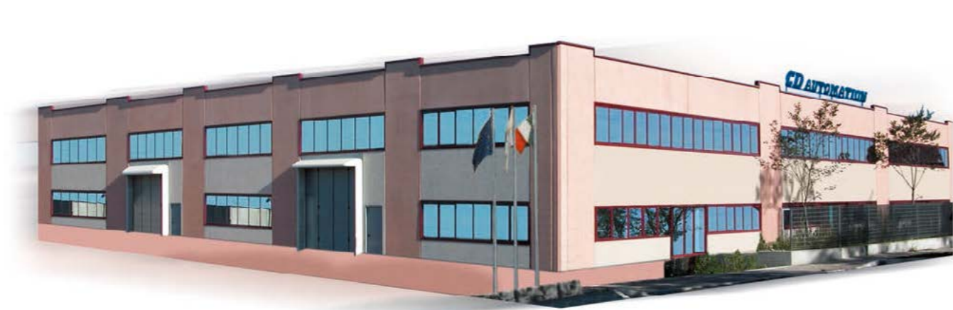
位于意大利米兰的莱尼亚诺 (Legnano-Milano) 的调功器生产工厂。
